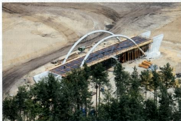
Rys. 15. Deskowanie głównego przęsła [3]
