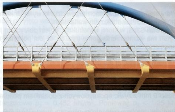
Rys. 16. Wieszaki lin całkowicie zamknięte i galwanicznie ocynkowane [6]
