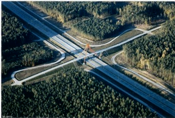
Rys. 10. WD-46 i fragment drogi gminnej relacji Nowogródek Pomorski – Ławy [3]
