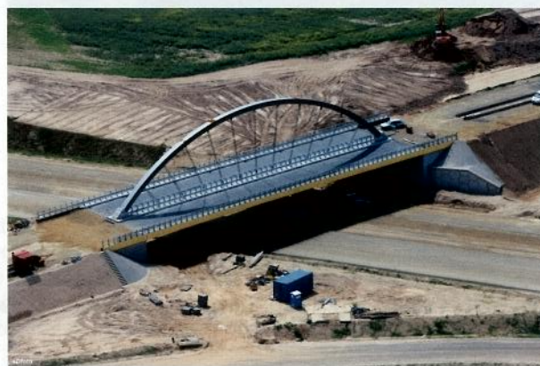
Rys. 7. Przestrzenny układ łukowy, tj. monolityczna belka sprężona wzmocniona łukiem stalowym [3]
