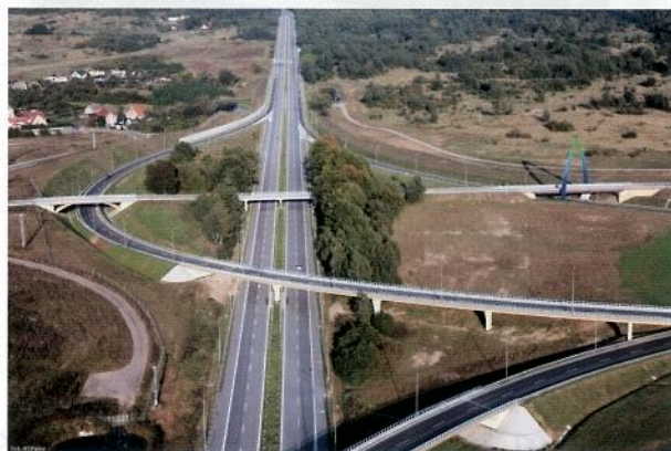
Rys. 2. Ulica Bielańska i trzy wiadukty (od lewej WD-1c, stary wiadukt nad autostradą A6 i WD-1d) [3]
