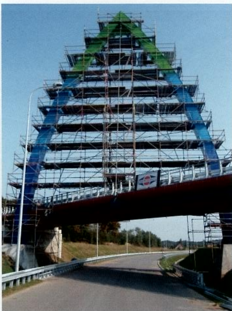
Rys. 4. Rusztowanie podczas robót malarskich [5]
