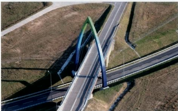
Rys. 5. Pylon o kształcie łuku gotyckiego, zukosowany względem osi podłużnej wiaduktu [3]
