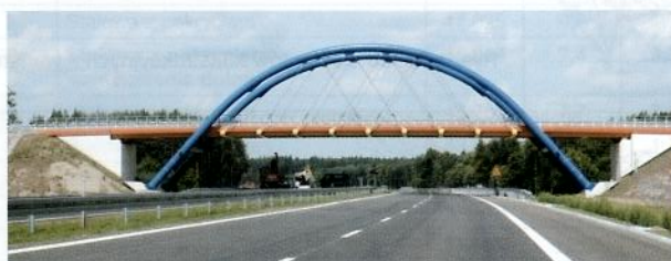
Rys. 17. Widok ogólny wiaduktu WD-58 w ciągu dnia [6]
