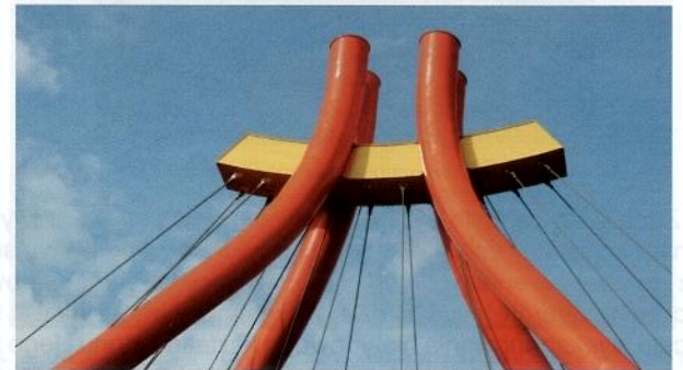
Rys. 12. Detal zawieszenia lin do rygla [6]
